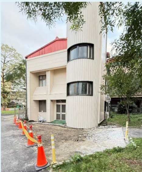
圖 1 教師宿舍前地坪整修
