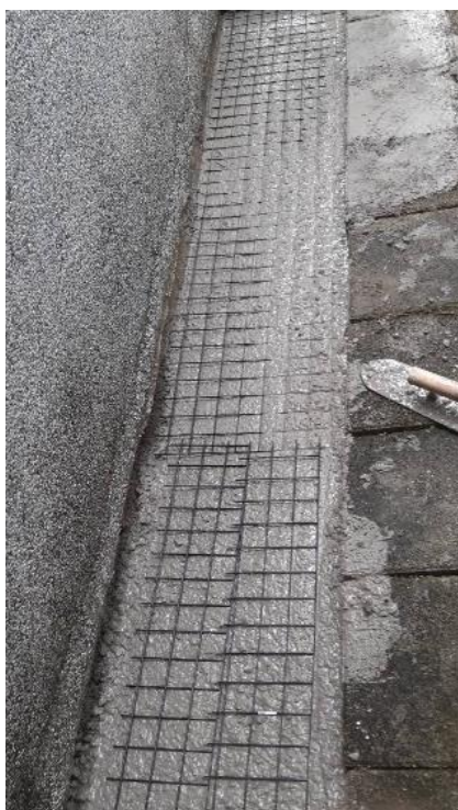
109/4 地坪灌漿：1樓地坪掏空，緊急灌漿修復，防止塌陷。
