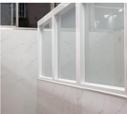
109/2 木棉廁所整修：師生能使用明亮又安全的新廁所。
